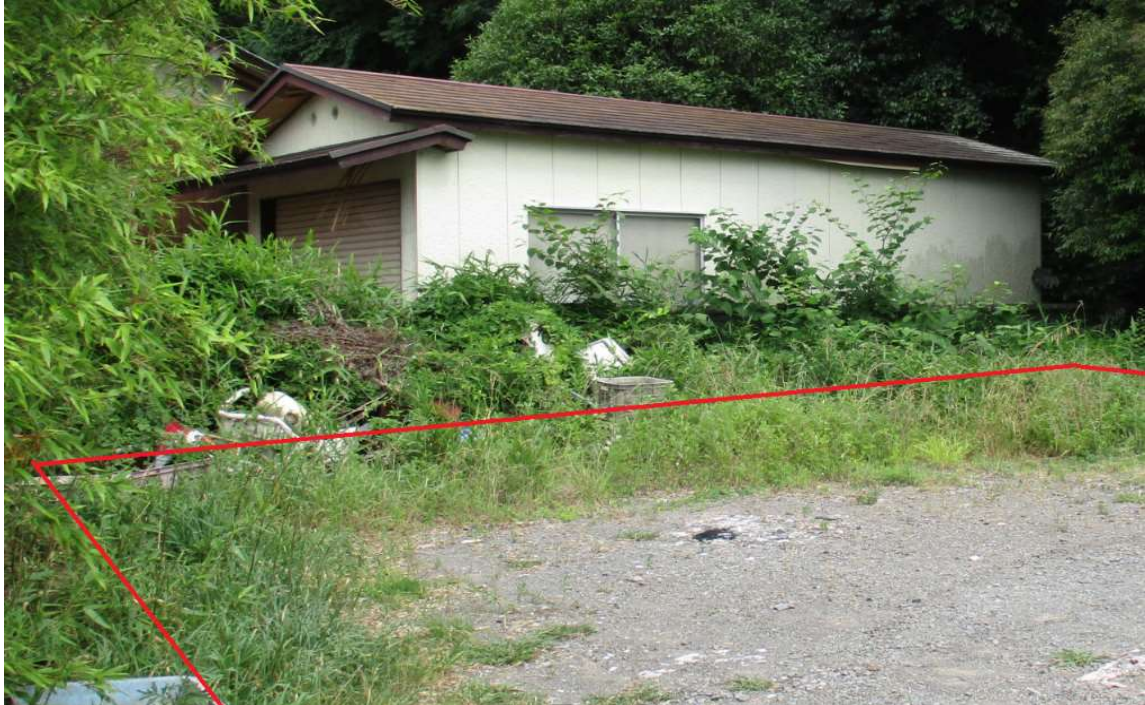
現場北西側から撮影
