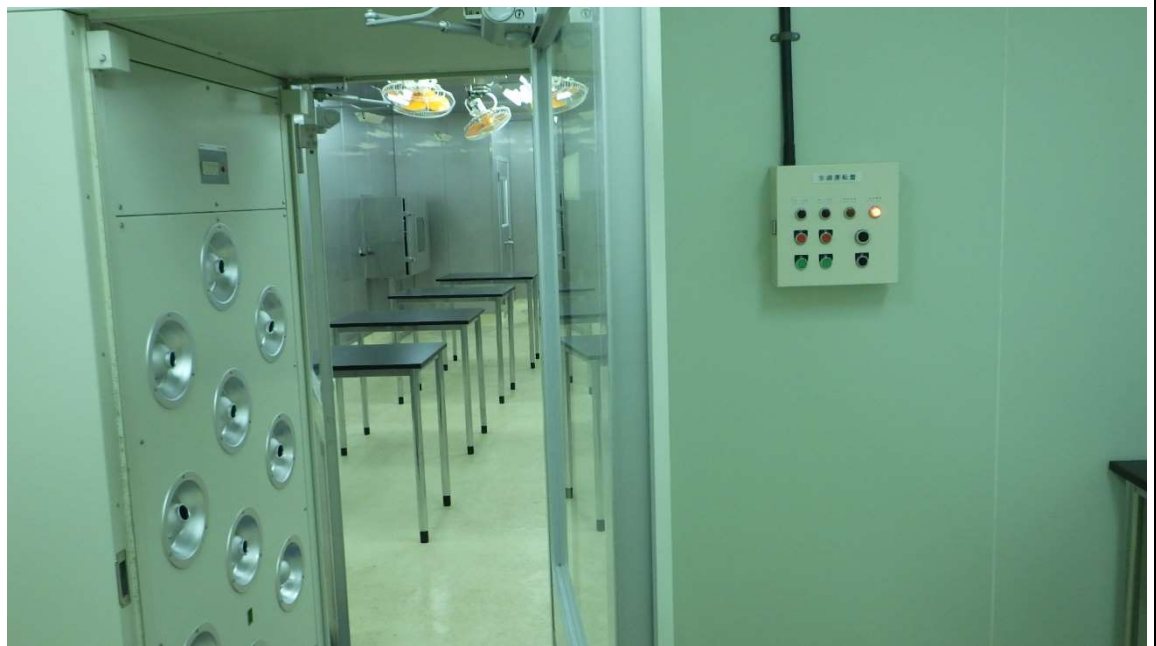
(建物番号357 内部クリーンルーム)
