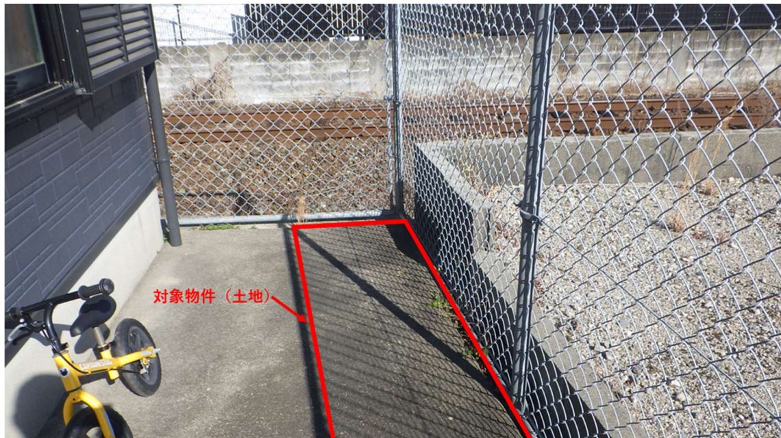
【対象物件を南側から撮影】
