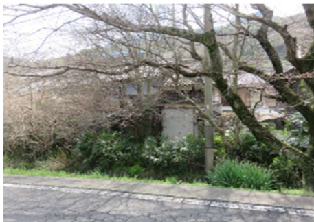
建物中央付近を北側の道路から撮影
