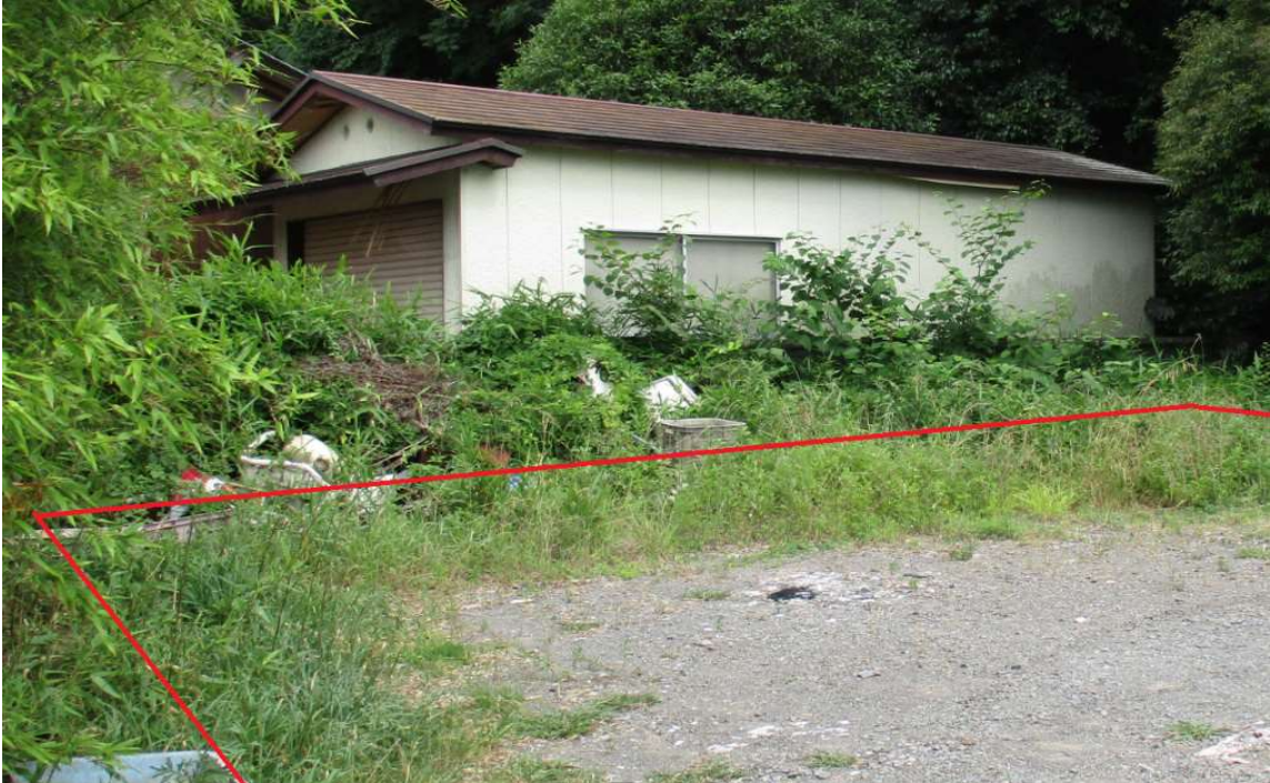
現場北西側から撮影
